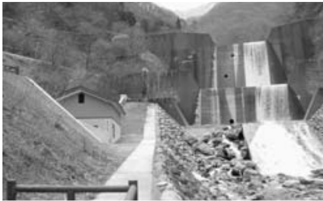
金山沢川のえん堤と水力発電所
