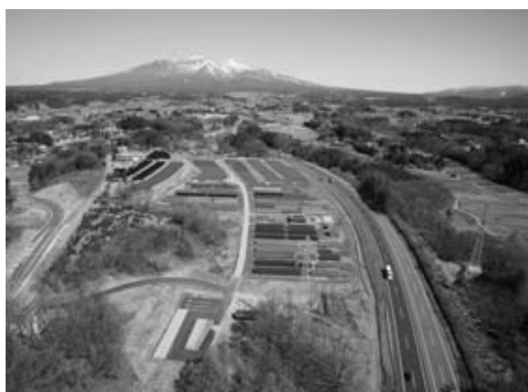
大規模電力供給用太陽光発電システム安定化等実証研究施設（北杜サイト）
