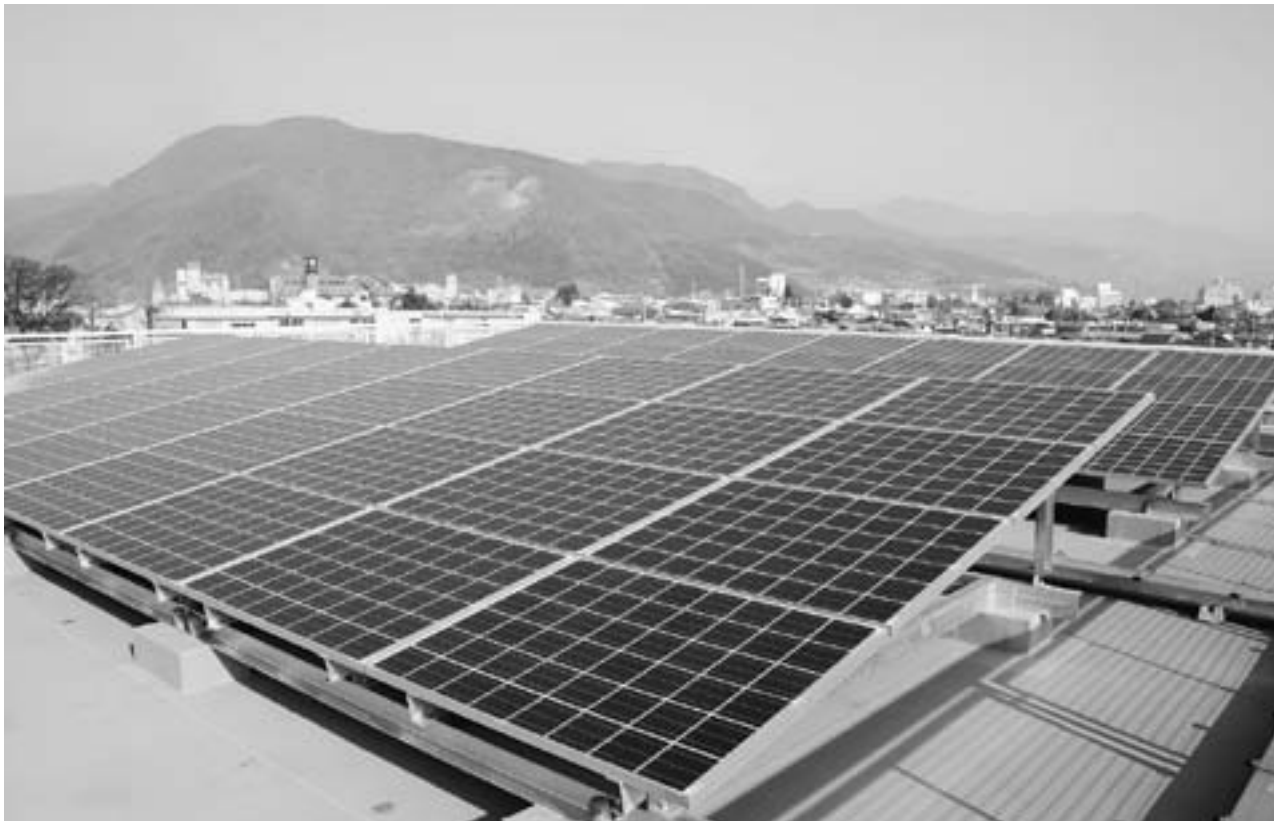
市役所南館に設置された太陽光発電設備
