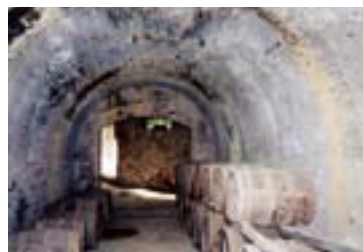
「土屋龍憲ワインセラー」 明治10年、ワイン醸造の技術習得のため渡仏した青年2人のうちのひとり、土屋龍憲が建設した半地下式レンガ造りのワインセラー。
