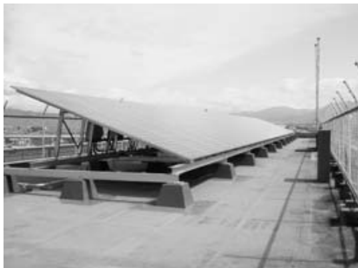
市内の学校に導入されている太陽光発電
