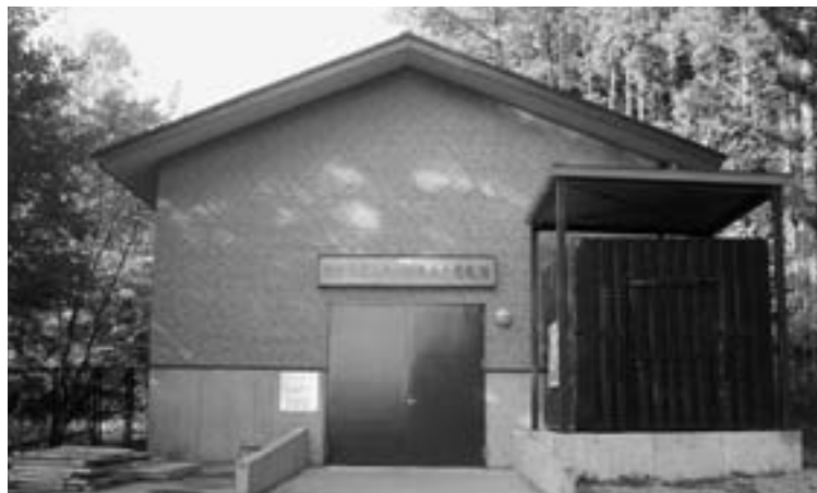
村山六ヶ村堰水力発電所
