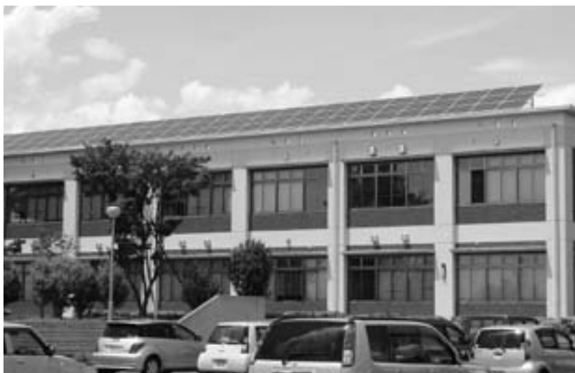
産業技術短期大学校に設置した太陽光発電設備（20キロワット）
