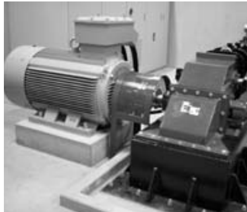
金山沢川発電所で使われているクロスフロー水車
