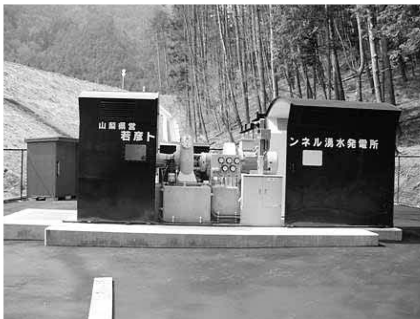
若彦トンネル湧水発電所
