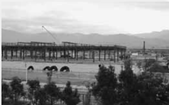
新山梨環状道路南部区間（区画整理スーパー街区SC建設中）
