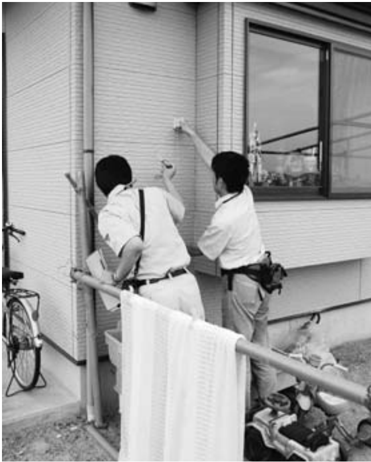
家の傾きを計っている様子
