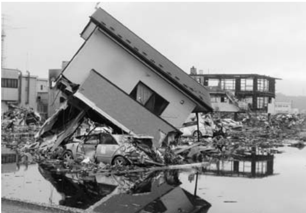
津波による住宅の倒壊
