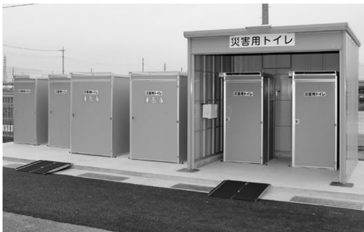
災害用マンホールトイレ
