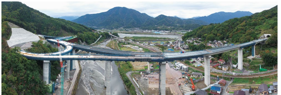
中部横断自動車道「下部温泉早川インターチェンジ」建設 写真提供：株式会社 リナン
