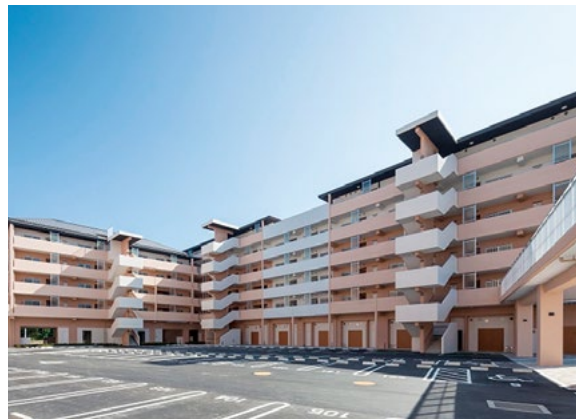
下和野災害公営住宅
