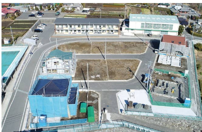
(左上)グリーンハイツ富士見(中央)転入世帯の建築が進む富士見台分譲地
