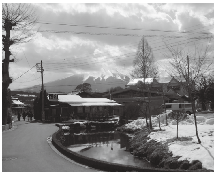
湧池線舗装工事及び無電柱化工事前
