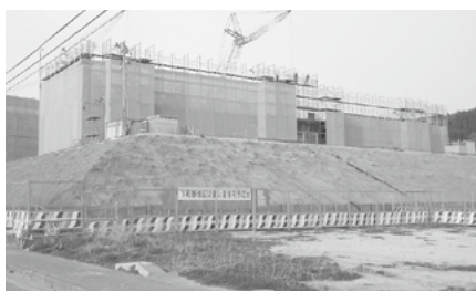
災害公営住宅(建設中)
