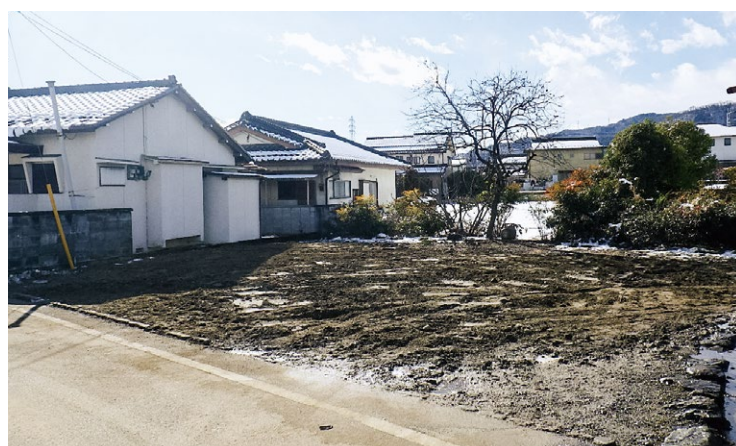
富士川町空き家解体後
