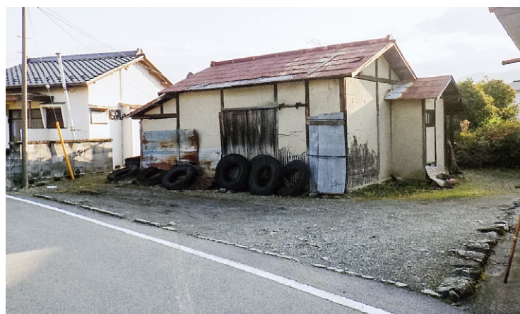
富士川町空き家解体前
