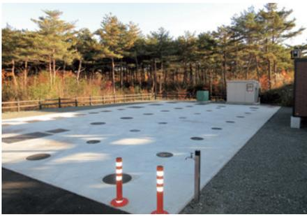
災害時の応急仮設トイレ機能を備えた浄化槽
